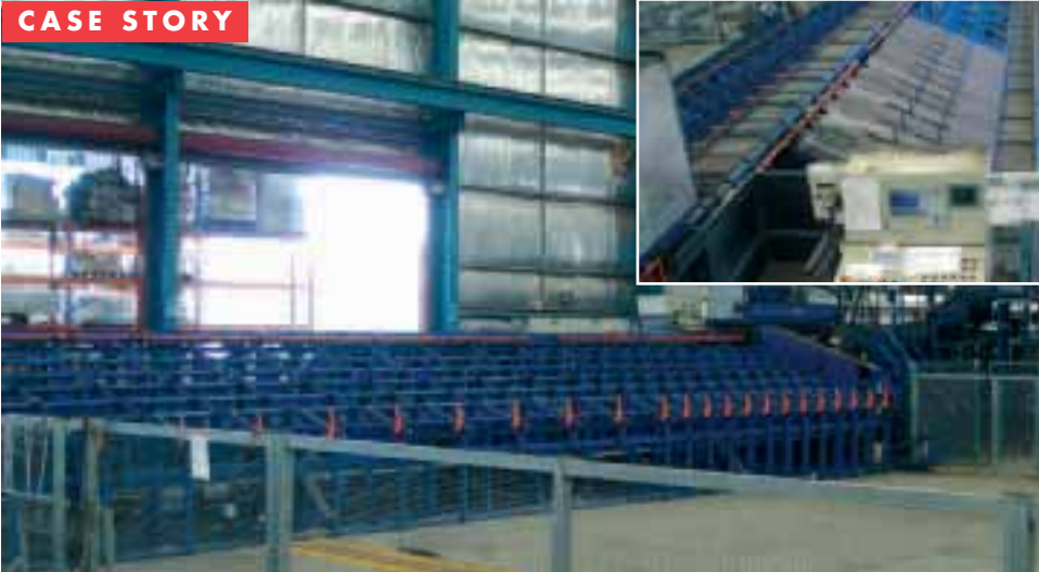
CADORMATIC 500 Shearline im Werk von Smorgon Steel in Sydney
